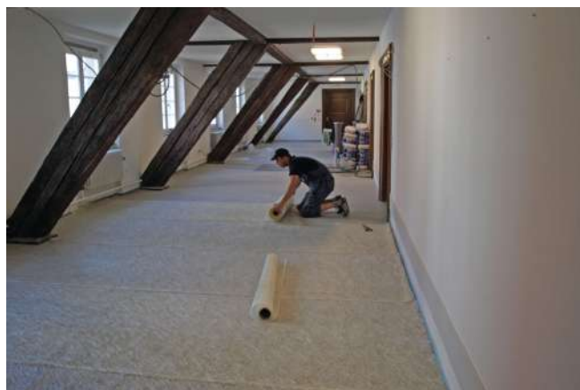
Leg UZIN RR 201 vlak op de te renoveren ondergrond.
